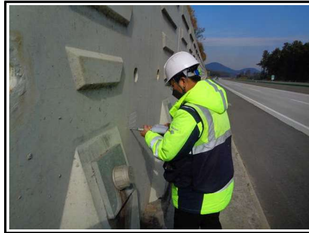
【그림 7.3.6】 슈미트해머를 이용한 반발경도시험 전경
